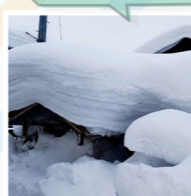
屋根が壊れそう!
