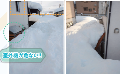
家の裏の駐車場から。1階は全て埋まっています。
